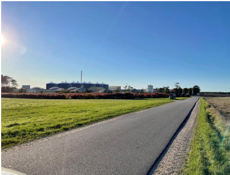
Anlægget set fra øst på Østenfjeldvej.
